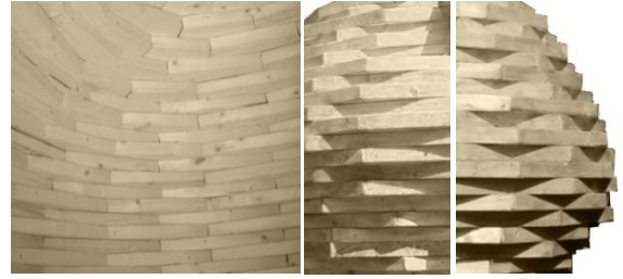
شكل (48) - أ- لقطة تشرح رص مداميك الاحجار المكونة للقباب في (المطعم - المكاتب) ب- طريقة مقترحة لرص مداميك الأحجار المكونة للقباب بالمشروع (المطعم - منطقة المكاتب) corbelled dome installation ستحدث عنها الباحثة لاحقاً
