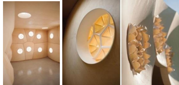
شكل رقم (٢٣) يوضح التحكم في دخول الإضاءة الخارجية بشكل ذاتي إستجابة للمتغيرات المناخية المحيطة . المرجع : https://oliverdavidkrieg.com/?p=675
