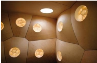
شكل رقم (١٦) يوضح أشكال الفتحات المستجيبة للرطوبة من الداخل
