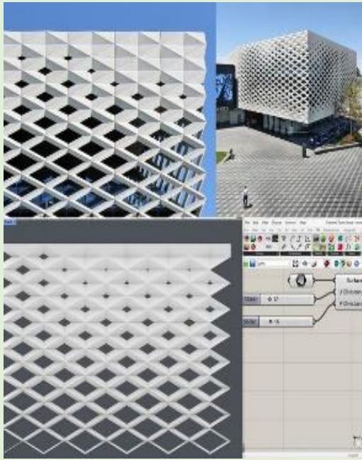
صورة (٤) توضح إمكانية إعادة إنتاج الزخارف المعقدة باستخدام الخامة
