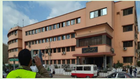
صورة (٢) توضح مبني محافظة الشرقية قبل وبعد الترميم بخامة (GRC-I) (تصوير الباحث)
