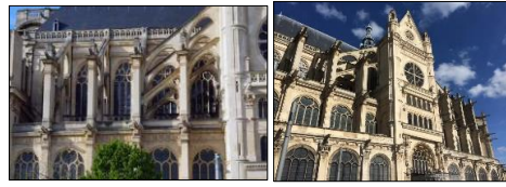
شكل (٣) يوضح الدعائم الطائرة التي شوهت في كنيسة سان بوسستاكس Saint-Eustache، في باريس، فرنسا، وغالبًا ما يظهران إحسانًا بالحركة
