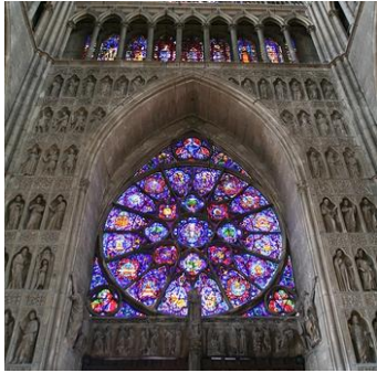
شكل (٦) يوضح النوافذ الزجاجية (روز ويندوز Rose windows) الشهيرة في نوتردام، وتمت إضافة هذه النوافذ الضخمة للزينة، كما وتسمح بدخول الضوء الطبيعي. المرجع: Gobillot, R. and J. Lemarie "Le Labyrinthe de la Cathedrale", Notre Dame de Chartres, June 1972.
