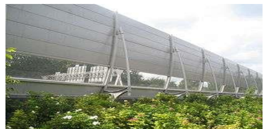
شكل رقم (١١) لحواجز الضوضاء في هولندا من الحواجز المختلطة
