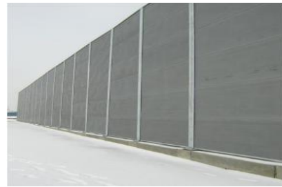
شكل رقم (٥) يوضح حاجز للضوضاء من الكتل الخرسانية
