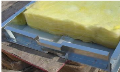
شكل رقم (٨) يوضح عزل الصوت داخل حاجز الضوضاء
