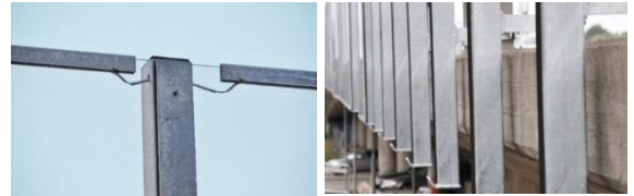
شكل (١٥) يوضح تركيب شرائح الزجاج والأعمدة المستخدمة للتدعيم
