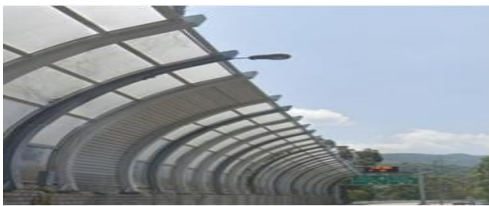
شكل (٣٢) يوضح تنسيق الحاجز مع إشغالات الطريق مثل تعليق الإضاءة على حاجز الضوضاء.
