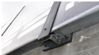
شكل (١٤) يوضح تركيب الزجاج والقطاعات المستخدمة من الحديد
