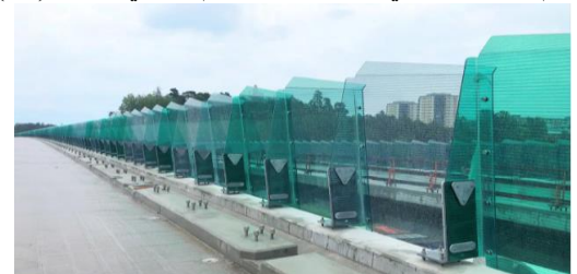
شكل (١٨) يوضح الاستغناء عن الأعمدة المجلفنة باستخدام دعائم من الزجاج الشاكوشي
