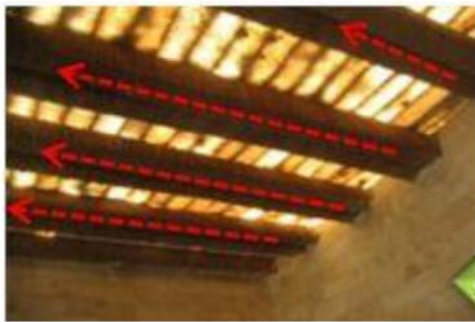
صورة (٤٤) توضح شكل الأسقف من خشب النخيل (EQI-2021) يتم تركيب الأسقف من خشب النخيل المعالج في بحيرة الملح، وذلك للتخلص من العصارة الجاذبة للحشرات القارضة.
