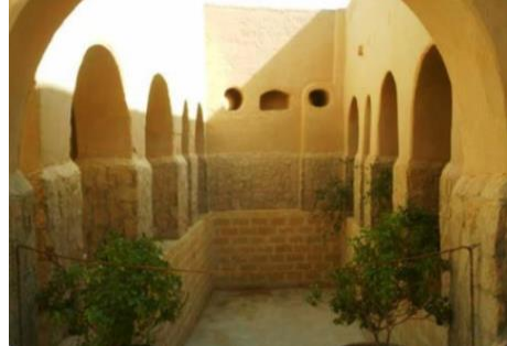
صورة ( ٤٨ ) توضح التصميم الداخلي البيني بواجهة سيوة من خلال كيفية استغلال الطراز المعماري لواجهة سيوة في تصميم الفتحات للاستفادة القصوى من الاضاءة الطبيعية لتحقيق الراحة الضوئية، وأيضا في تحقيق التهوية الصحية لجو صحي نقى لتحقيق الراحة الحرارية. (EQI-2021)
