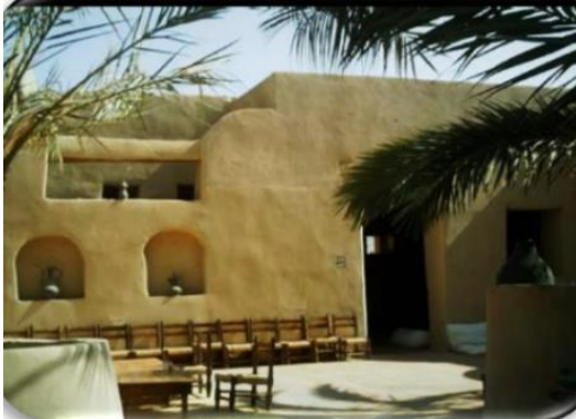
صورة (٤٩) توضح الطراز البنني لواجهة سيوة التي لا تزيد عن طابقين فتحقق الراحة الحرارية فلا يحدث احتباس حراري كما في المباني ذات الطابق العالية. (EQI-2021)
