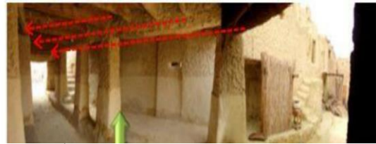
صورة (٤٧) تظليل الشوارع ليقفل من شدة الحرارة صيفاً (EQI-2021) وقد تم توجيه البيوت بحيث تفتح الشبابيك في الإتجاه البحري وبقابلها فتحات في الإتجاه القبلي لخلق تيارات هوائية وتعمل الأحواش الداخلية والأفنية عمل ملاقف الهواء.
